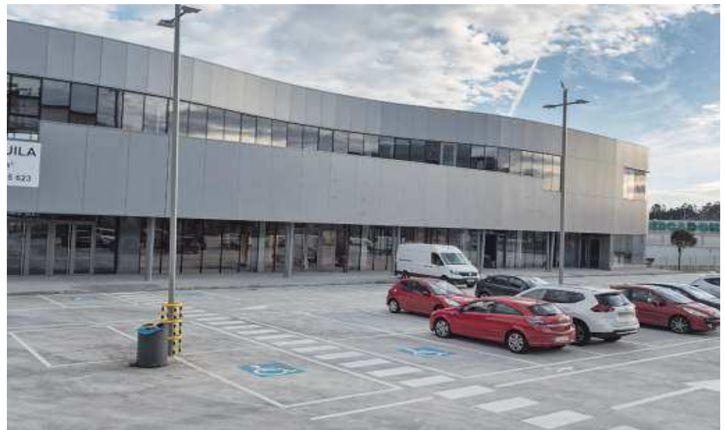
JYSK estará en el local central del bajo de la nave situada tras el McDonald's de Costa Vella. PACO RODRÍGUEZ
