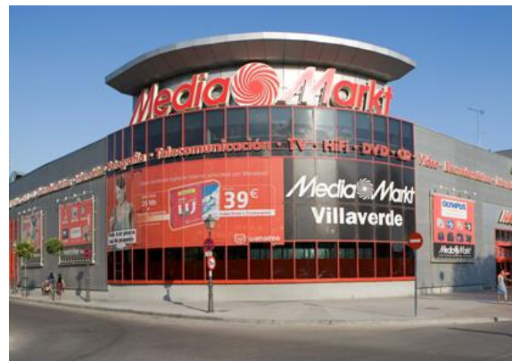
Fachada Principal del edificio Comercial
