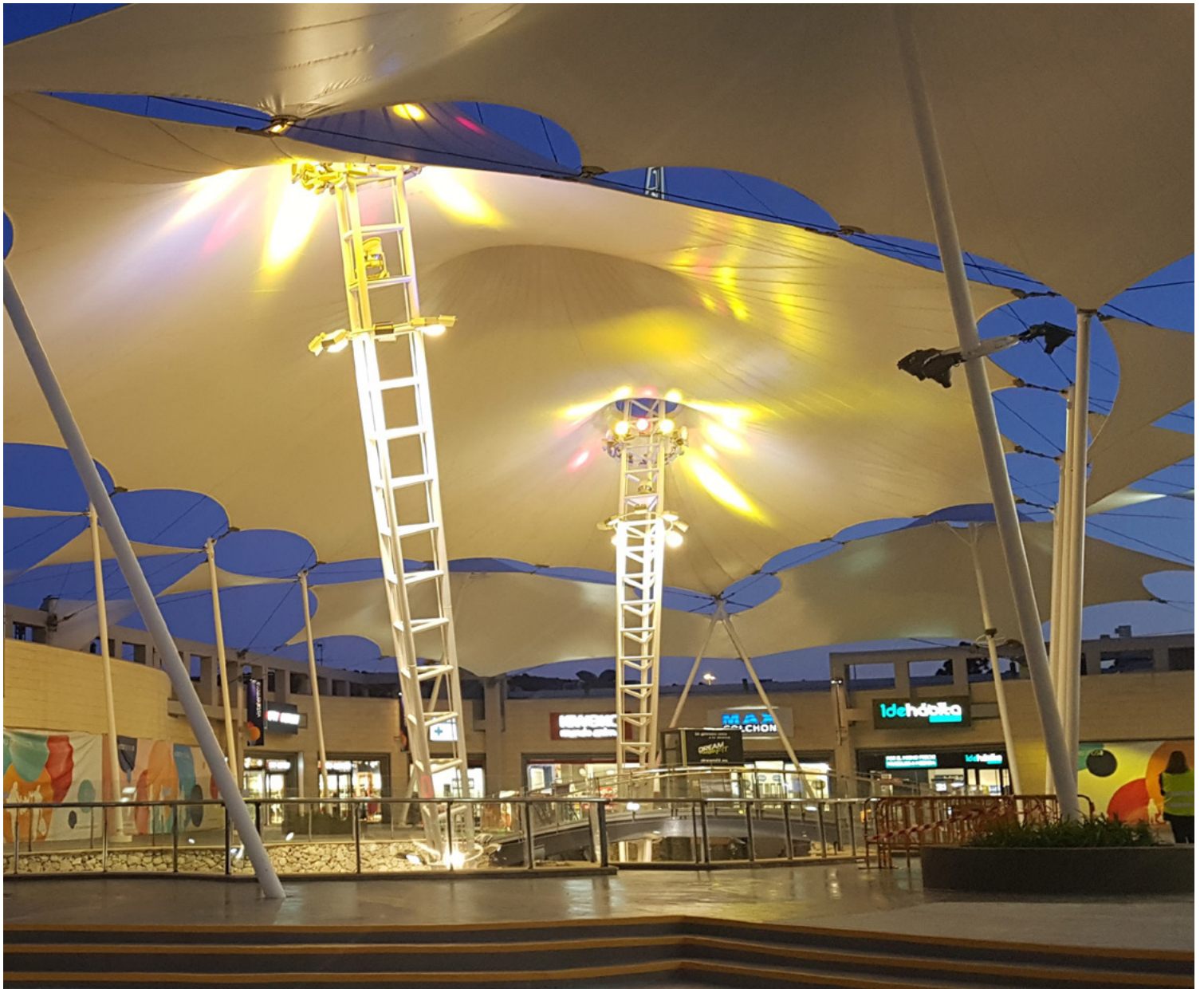
Centro comercial Vistahermosa (Alicante)
