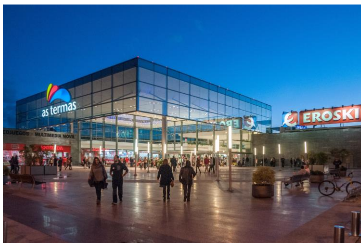
Fachada del centro comercial adquirido por LRE
