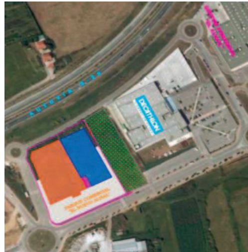
Vistas aéreas de la localización del parque comercial Nuevo Alisal
